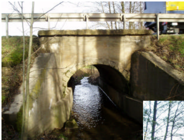
altes Brückenbauwerk mit stark beeinträchtigter Standsicherheit
