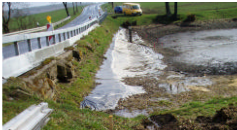
Zustand des teichseitigen Straßendamms und der alten Stützwand vor dem Ersatzneubau
