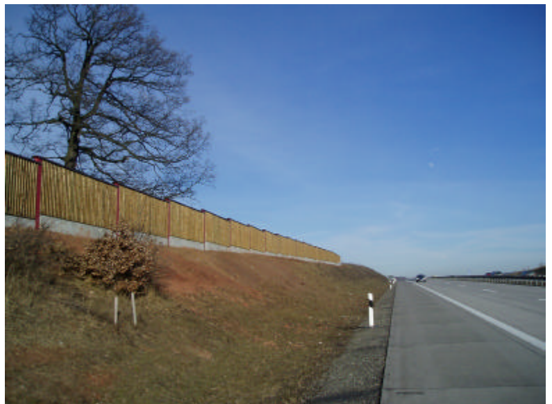
Lärmschutzwand 1 bei AS Zwickau Ost Verlängerung der bestehenden Lärmschutzwand mit Holzausfachung
